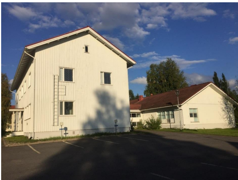
Virastotalo 3, jonka matalampi laajennusosa on rakennettu 70-luvulla.
