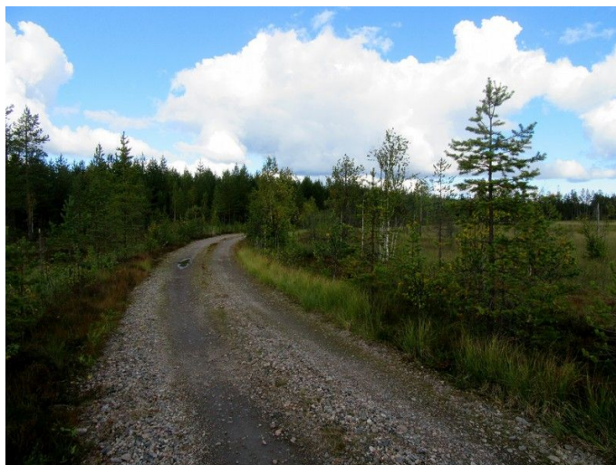
Kuva 9. Tielinjaus Kuivauslammen lounaispuolella kuvattuna pohjoiseen.
