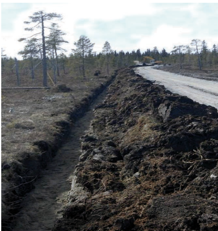
Kuva 3-14. Maakaapelit sijoitetaan ensisijaisesti huoltoteiden yhteyteen (Nordisk Vindkraft Oy).
