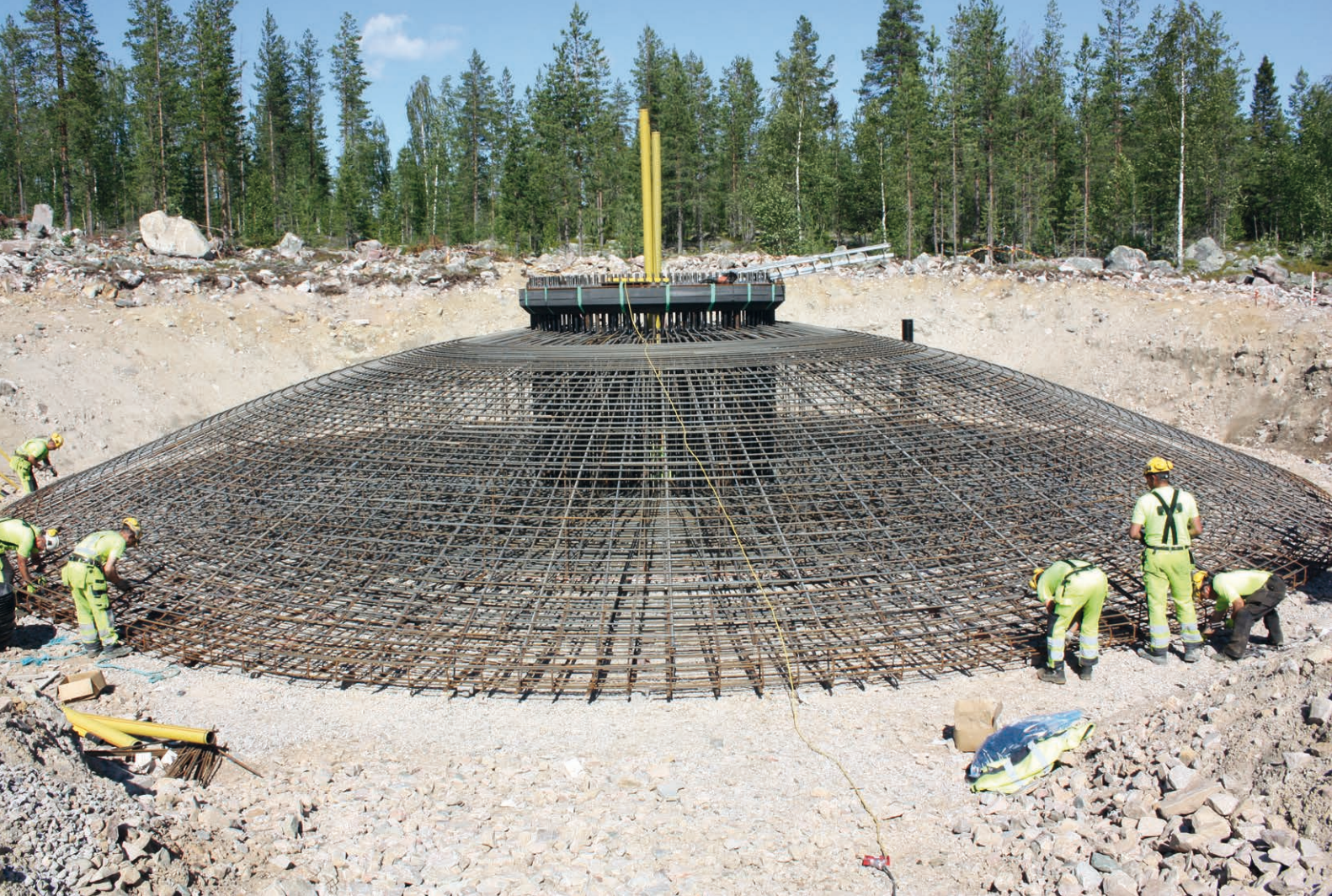
Kuva 3-8. Maanvarainen teräsbetoniperustus raudoitettuna ennen betonivalua, Tervola.
