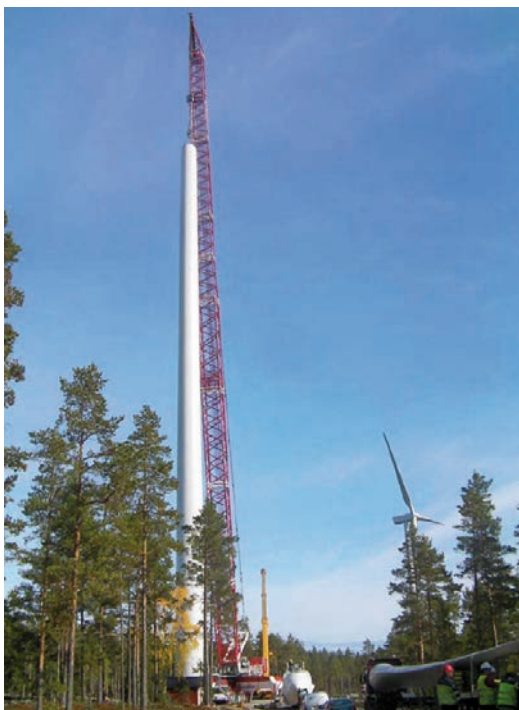
Kuva 3-28. Tuulivoimalan pystytys (Nordisk Vindkraft Oy).
