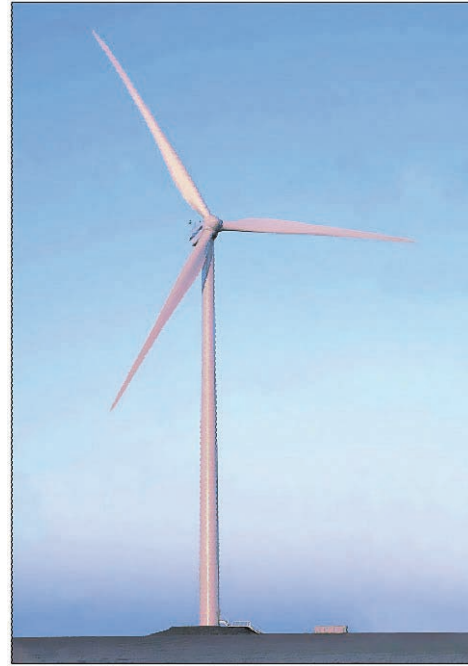
Kuva 3-6. Esimerkkikuva lieriötornirakenteisesta tuulivoimalasta (Nordisk Vindkraft Oy).
